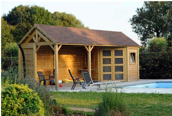
La partie abri, très lumineuse grâce à la double porte vitrée, peut recevoir la technique de la piscine. Le châssis tombant permet l'aération de l'abris et le passage de cordelière électrique ou d'un tuyau d'arrosage.
