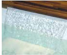
La lame d'eau est une petite cascade intégrée à la margelle et qui génère un petit bruit d'eau bien agréable à proximité du bassin. Idéalement alimentée par une pompe dédiée (10m<sup>3</sup>/h). Elle peut éventuellement l'être via le circuit de refoulement de la piscine à condition d'installer un by-pass qui condamnera la (ou les) buse(s) de refoulement quand la lame d'eau est en action.
