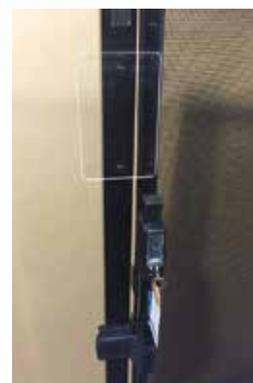
Plaque de plexiglas à fixer du côté de la serrure : bloque le passage de mains au niveau de la serrure du portillon KIT LOC
