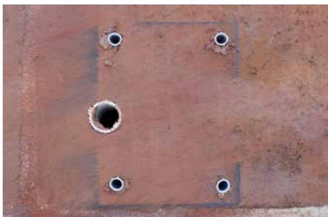
**Percer :** effectuer quatre perçages par platine selon le diamètre des chevilles de fixations et 1 pour le piquet de la barrière Beethoven selon le modèle : Ø 16 ou Ø 30 mm. Le manchon pour le premier piquet de la barrière se fixe dans l'encoche prévue sur la platine.
